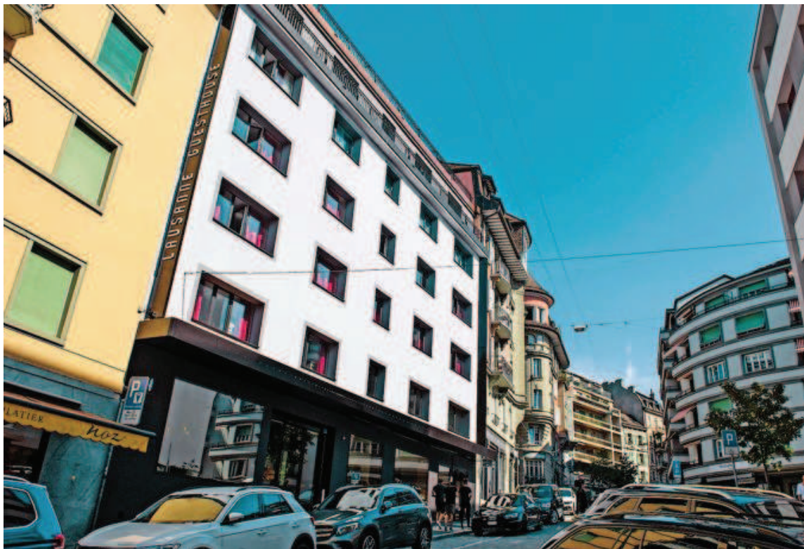
Le nouvel écrin du Guesthouse a été réalisé en soignant les matériaux et l'isolation. Vanessa Cardoso
